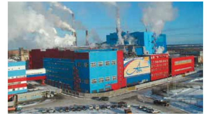
АО «Архангельский ЦБК», Выпарная станция ТЭС-2 г. Архангельск
